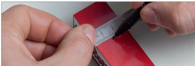
Abb. 34: Position der Ultraschallkapsel anzeichnen
